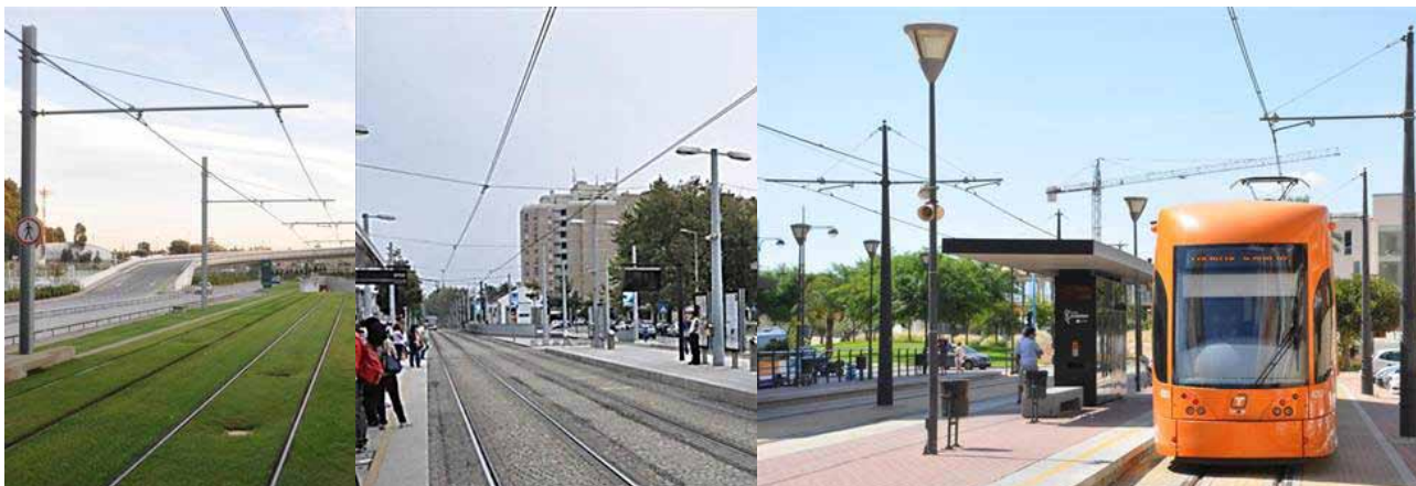
Figur 9-4: Køreledningsanlæg med 1) Sidestillet mast for to spor, 2) wirefelt mellem master og 3) midtstillet mast for to spor hhv. sidestillet mast for et spor.
