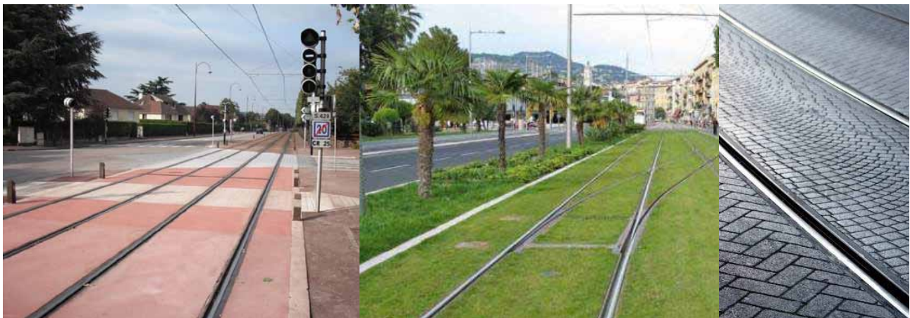
Figur 9-1: Forskellige typer overflade i sporkonstruktionen med rilleskinne.
