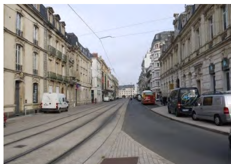
Eksempel på facadeophængte køreledninger
