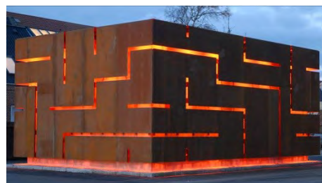
Eksempel på teknikbygning i cortenstål
