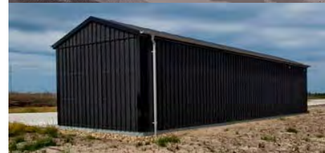
Eksempler på transformatorstationer
