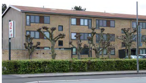
Formklippede træer samt lave hække foran etagebebyggelse beliggende syd for krydset med Saxovej.
