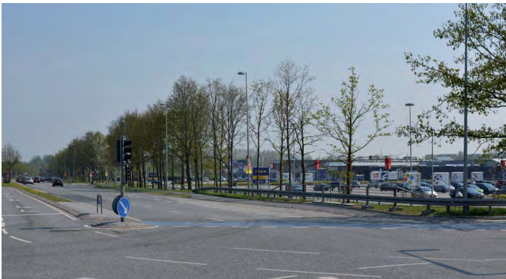
Dagens situation i krydset mellem Ørbækvej og Stærmosevej.
