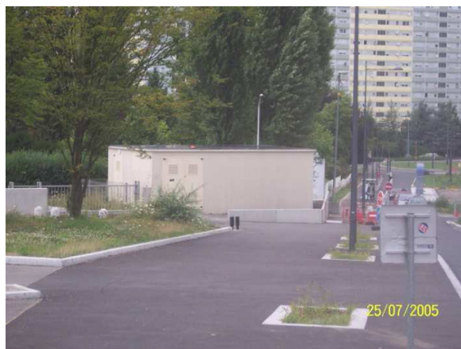
Foto af 60 m 2 omformerstation ved letbane i Frankrig. Omformerstationerne ved letbanen i Odense er ca. dobbelt så store (120 m 2 )
