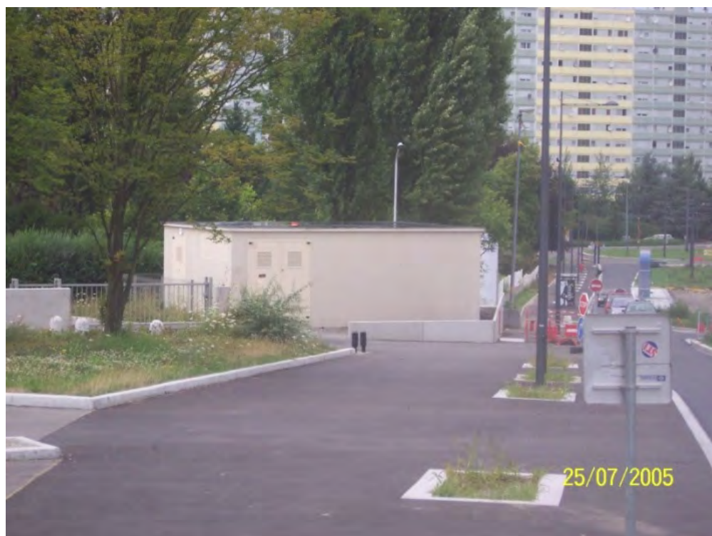
Figur 4.3 Foto af 60 m 2 omformerstation ved letbane i Frankrig. Omformerstationerne ved letbanen i Odense er ca. dobbelt så store (120 m 2 )
