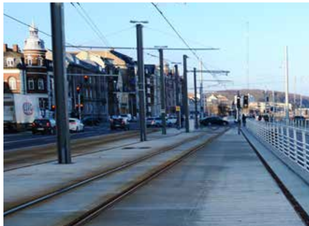
Eksempel på slab track ved Aarhus Havneplads, Aarhus Letbane. Foto: COWI
