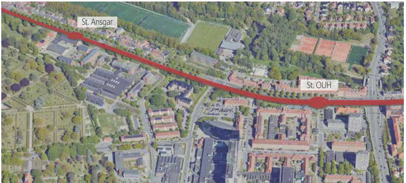
Skråfoto af letbanens linjeføring på Søndre Boulevard, med St. Ansgar og St. OUH.
