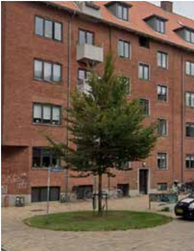
Bytræ med stort plantehul. Foto: Google Streetview
