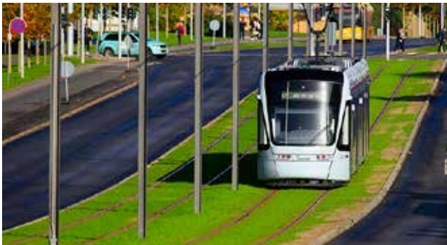
Eksempel på letbanetracé med græsoverflade og rilleskinner. Foto: Aarhus Letbane, COWI
