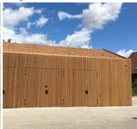
Transformerstationer med grønt sedumtag. Foto: Odense Letbane
