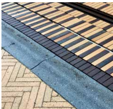
Kantafgræsning af letbanen med bordursten i granit. Foto: Odense Letbane
